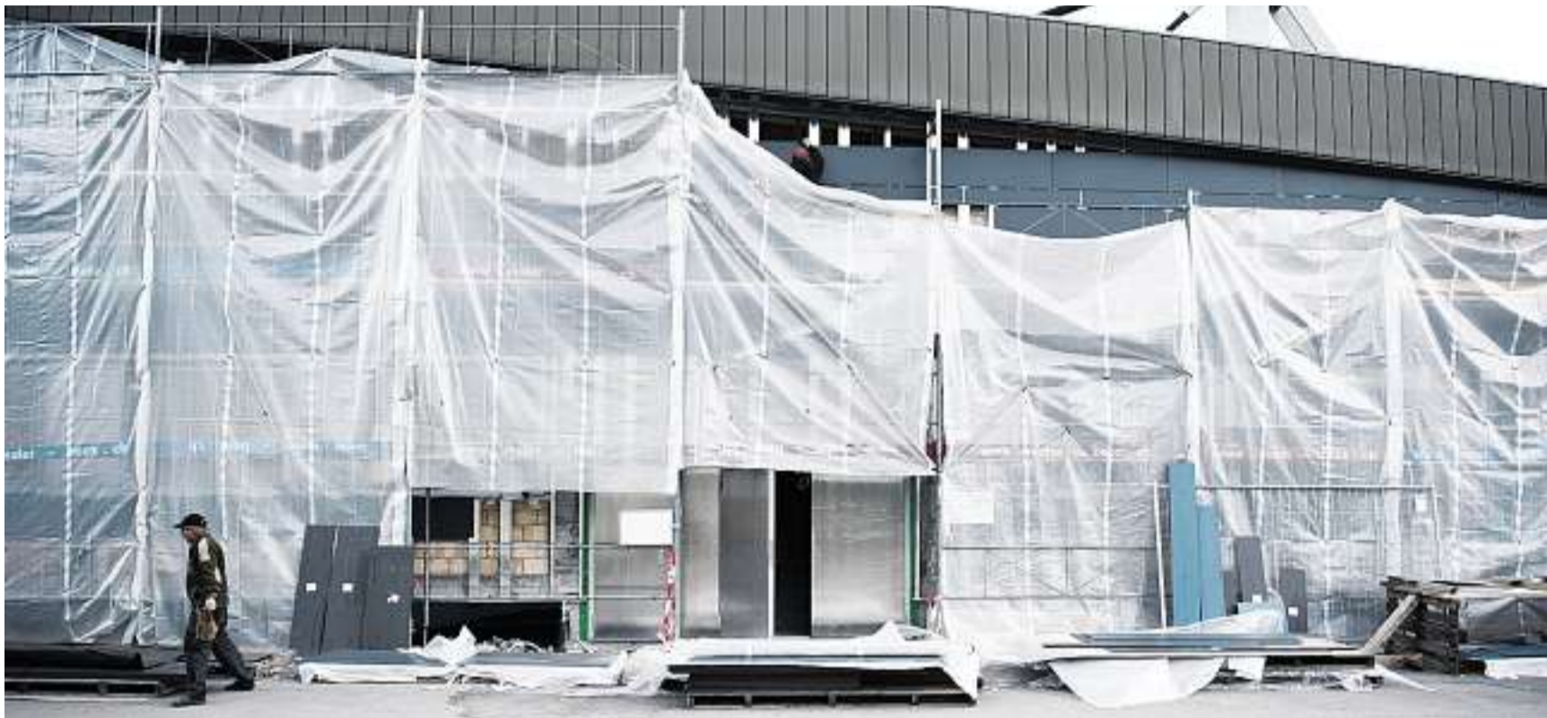
Sicherheit (noch) nicht gewährleistet: An den Notausgängen des neuen Arosar Eishockeistadions wird intensiv gearbeitet.
